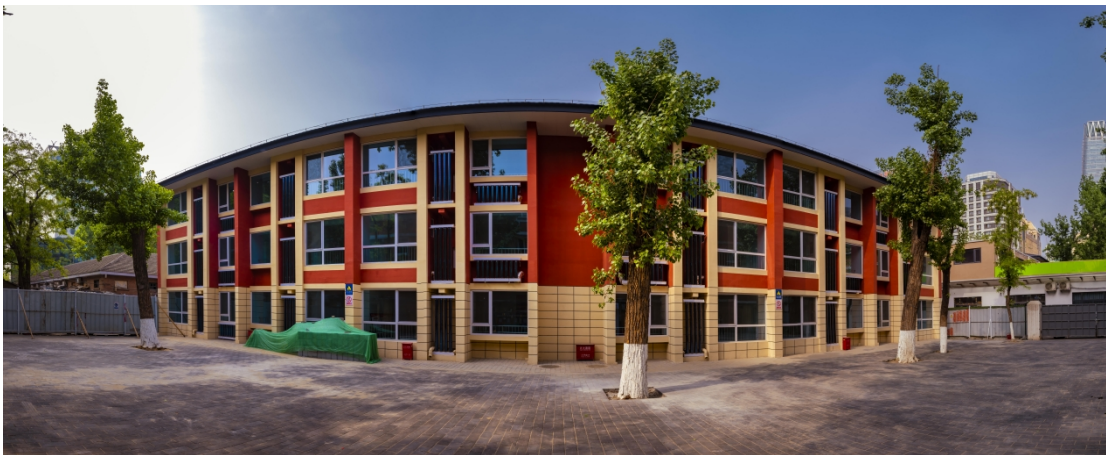
北京市首个危旧楼拆除重建项目——光华里 5、6 号楼
