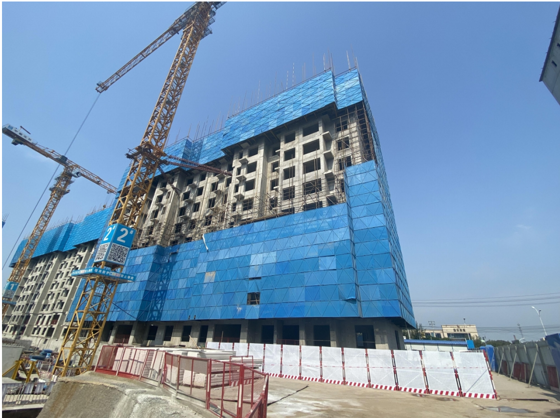
通州新城项目完成主体结构封顶
